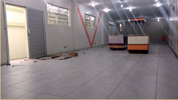
Início da reforma do salão principal Sede Social Assutef-CT.
